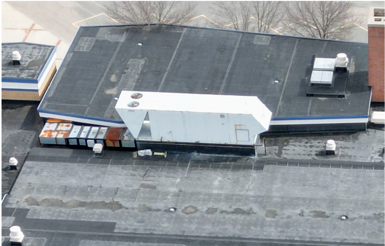
Existing Aeon 60 Ton RTU
